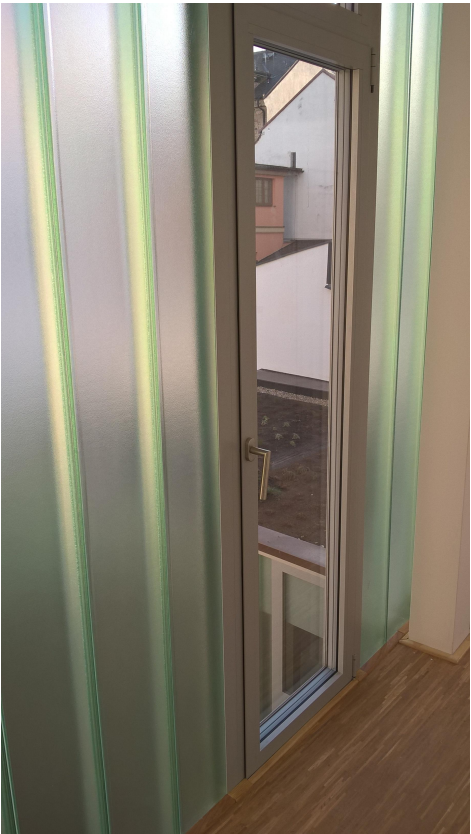
Okno v kopilitu, pohled z interiéru
