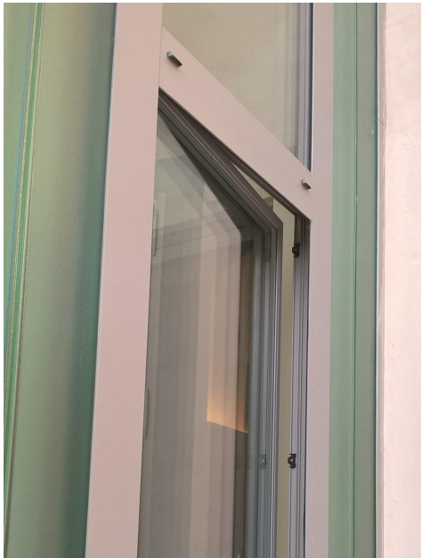
Horní rám okna v kopilitu
